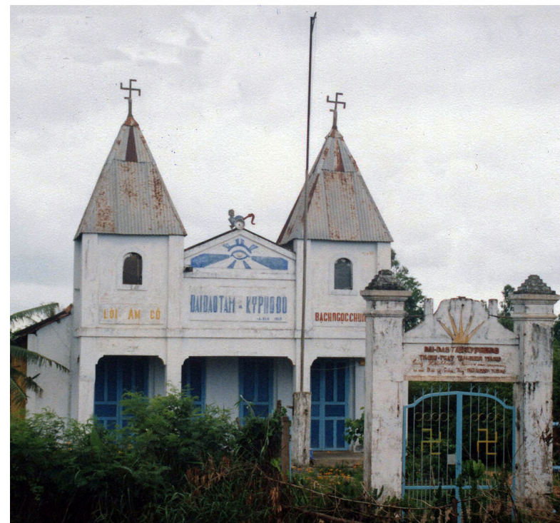
2. Bình Nghi (thánh thất): ấp Bình Hòa, xã Bình Nghi, huyện Gò Công Đông, tỉnh Tiền Giang. [Hội Thánh Cao Đài Ban Chính Đạo] (tên cũ: thánh thất Tân Duân Trung)
